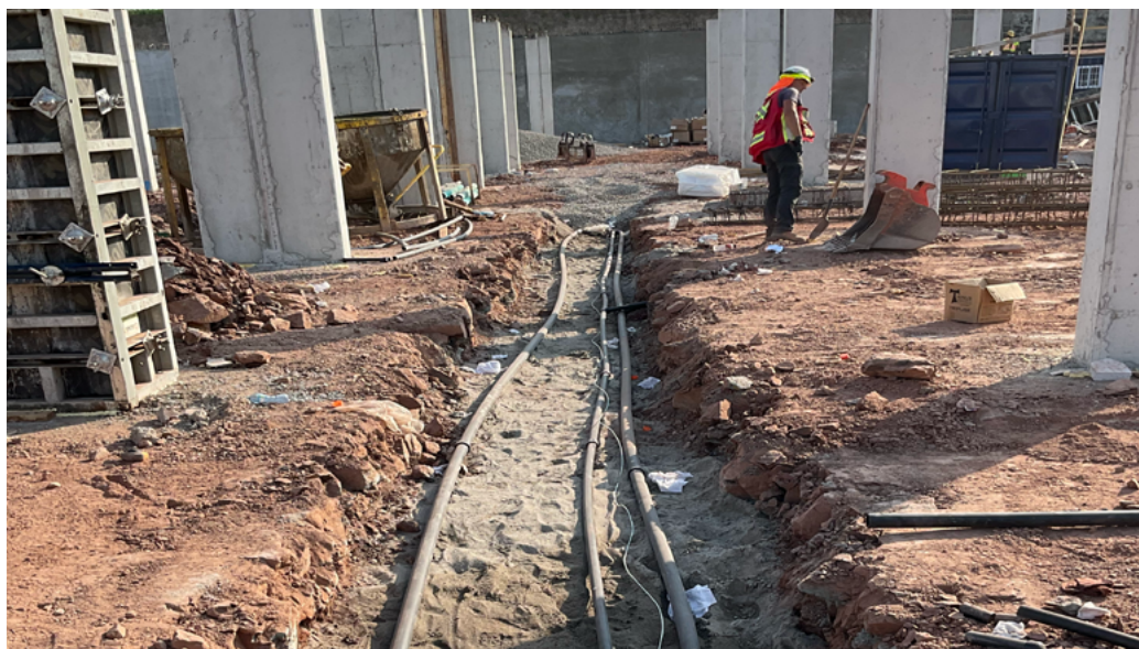
Photo fournie par l'Association géothermique de l'Ontario
