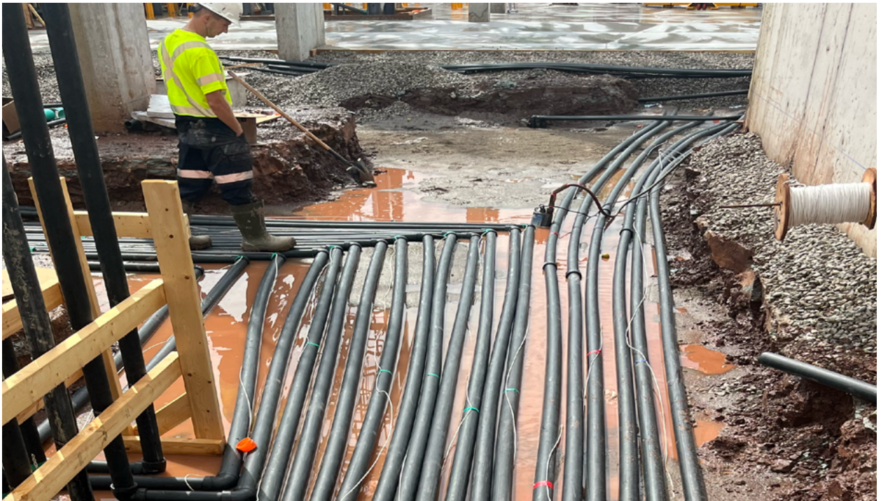
Photo fournie par l'Association géothermique de l'Ontario
